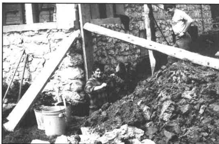
Ivko in Franček se delata, da delata. Pomembno je da so temelji podbetonirani.
