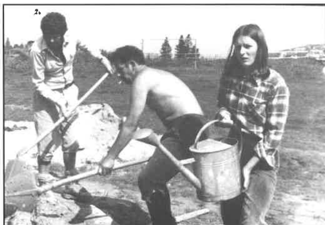
Betonska veselica - brez izjeme, tudi za vodilne ude društva
