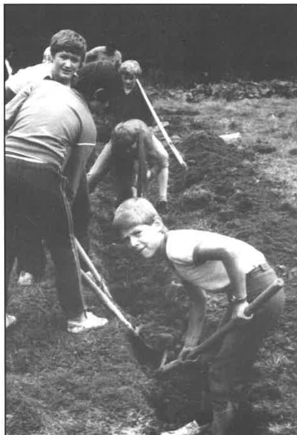
Izkop za kanalizacijo - na mladih svet stoji in tudi društvo
